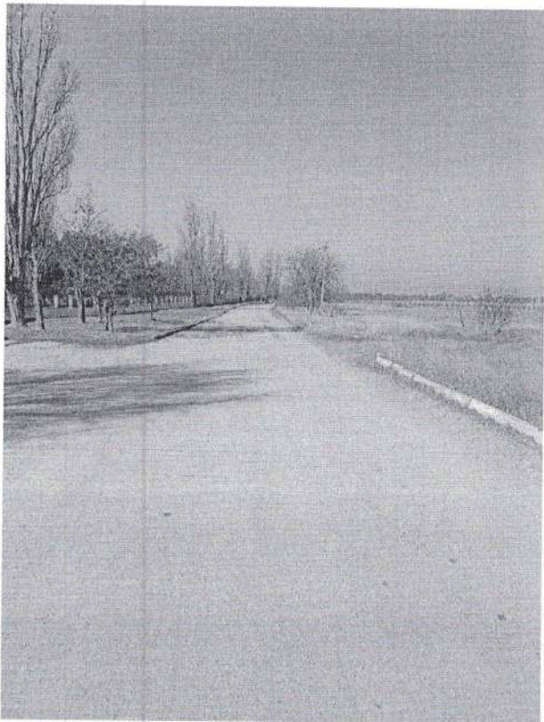
Тротуар (ул. Набережная 9)
